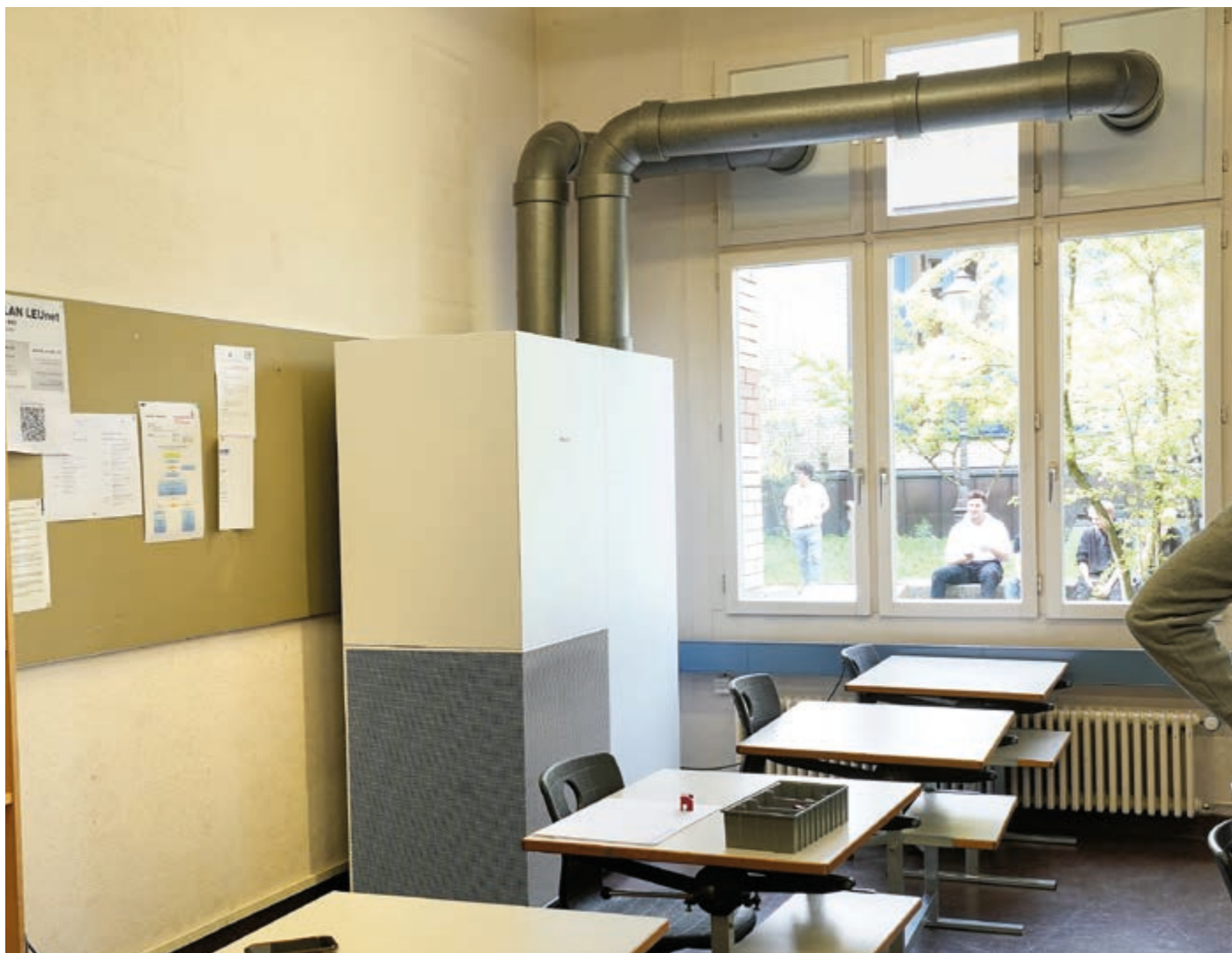
Peter Amacher plante mit seiner Baugewerbeklasse eine mechanische Lüftungsanlage, die anschliessend von Fachleuten eingebaut wurde.
